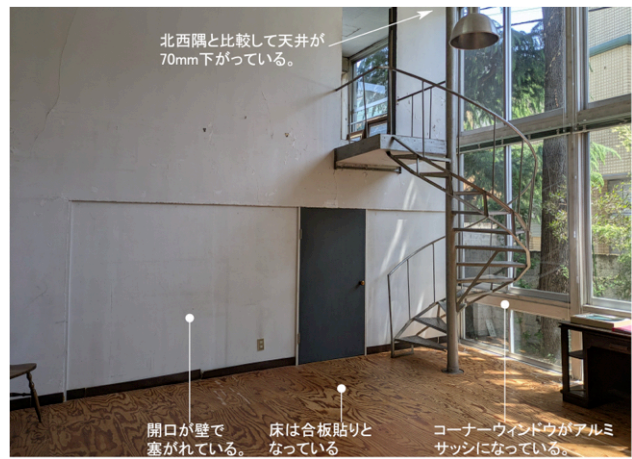
図 3-6 現況写真 3(内観)
