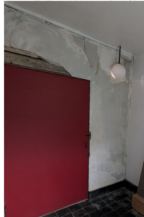
図 3-28 建具枠の漆喰留め収まり
