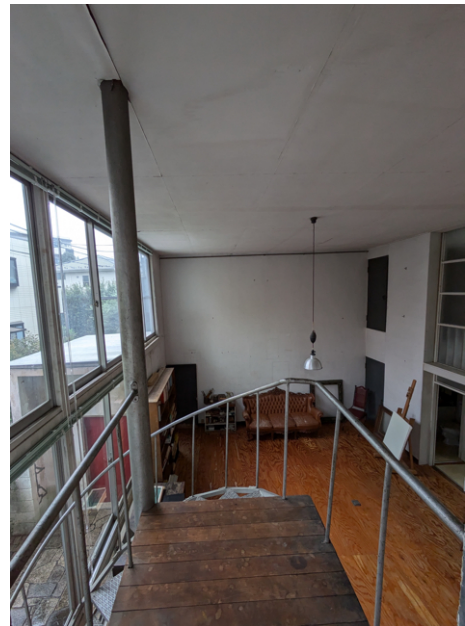
図 3-27 踊り場に残る米松とクロス張り天井
