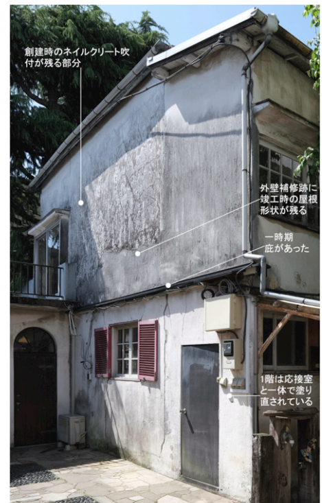
図 3-25 外壁の保存状況
